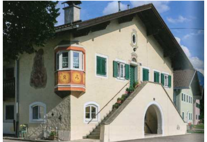
Die vom Architekten Helmut Erdle geplante Südtiroler Siedlung Reutte zeichnet sich durch viele typische Bauelemente aus wie Balkone, Erker und Fensterbalken.
