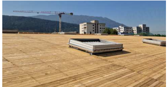
Die Dachfläche der Ennstalhalle während der Bauarbeiten
