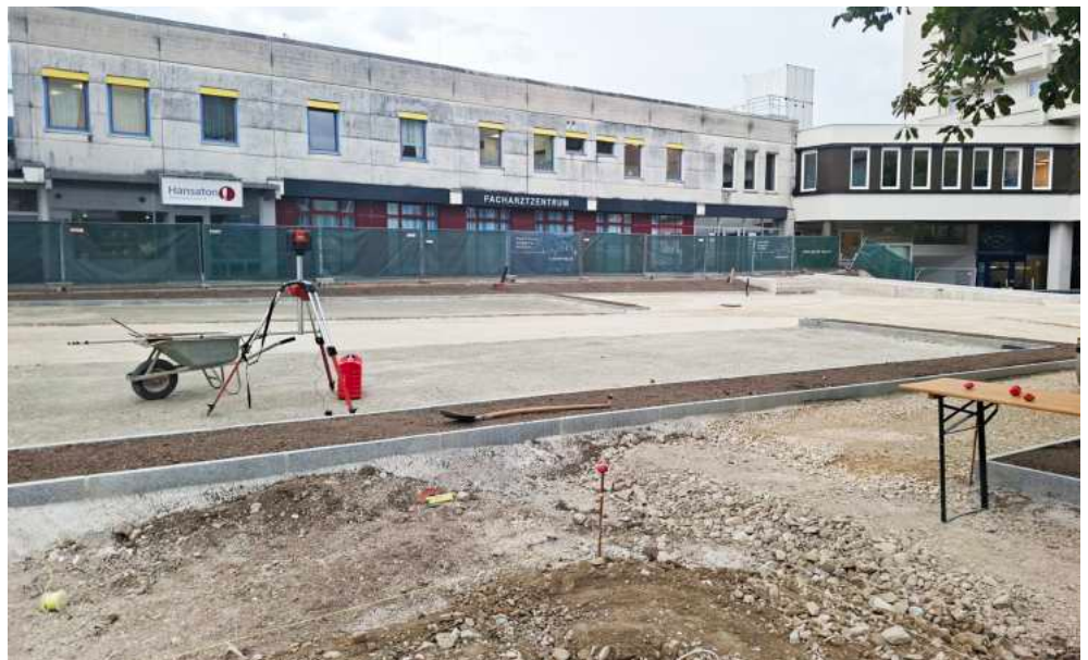
Ein aktueller Blick auf die "Marktplatz-Baustelle"
