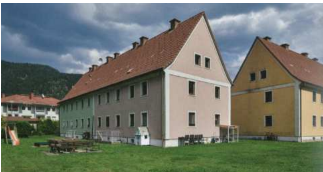
Südtiroler Siedlung in Friesach: Der einheitliche Bauplan vonseiten der Gauleitung wurde nicht nur in Liezen, sondern auch in Friesach realisiert. Quelle: Mitterer, Südtiroler Siedlungen, 2022, S. 283
