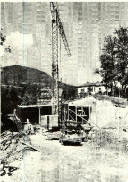
Der neue Trinkwasserbehälter auf dem Kalvarienberg soll im Juli 1987 fertiggestellt sein. Er faßt 2000 Kubikmeter Wasser und sichert den Trinkwasserbedarf von Liezen auf weite Sicht. Nach der Fertigstellung aller Betonwände und Einrichtungen wird das Bauwerk fast zur Gänze zugeschüttet und die neue Fläche bis zur Kalvarienbergkirche durch Grünanlagen gestaltet.
