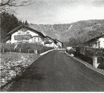
▲ Die Sanierung **Höhenstraße** und **Röthweg** wurde im heurigen Jahr durch das Aufbringen einer Asphaltverfleißschicht abgeschlossen.
