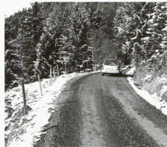
▲ 1100 lfm des **Hinteregger Weges** wurden in Form einer mechanisch stabilisierten Tragschicht mit Recyclingasphalt und einer Oberflächenbehandlung mittels Bitumen und Splitt staubfrei gemacht. Der Erhaltungsaufwand für die nächsten 7 Jahre wird mit dieser Maßnahme beinahe auf Null gesenkt. Die restliche, noch geschotterte Weglänge, wurde neu gegrädert und eingewalzt. Somit können die Bauern im Sommer wieder Milch liefern, anstelle die Butter aus den Kannen zu stechen.
