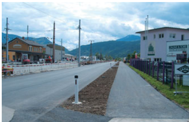
Durch einen Grünstreifen getrennt verläuft südlich der Schönaustraße der neu angelegte Fuß- und Radweg.
