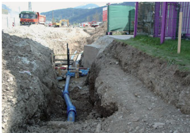
Im Zuge des Ausbaues der Schönaustraße mussten auch Teile der Wasserleitung neu verlegt werden.
