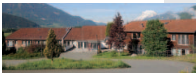
Auch eine Kinderkrippe wird im umgebauten Gebäude am Sonnenweg Platz finden.
