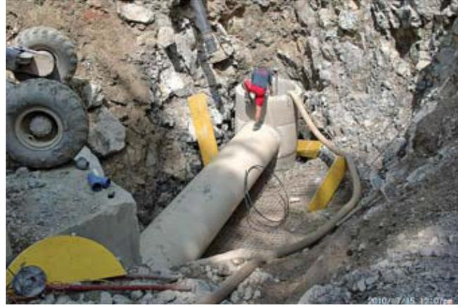
Der neue Quellsammelschacht weist einen Durchmesser von 150 cm auf. Das Verbindungsrohr zum bestehenden Bauwerk einen von 100 cm.
