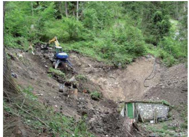
Für das Freilegen der Quelle waren umfangreiche Erdarbeiten – überwiegend in steilem und unwegsamem Gelände – notwendig.
